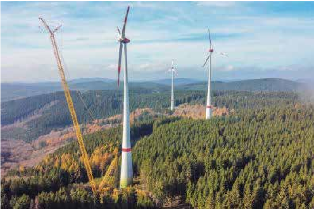
De omvang van de bouw van een windmolen
