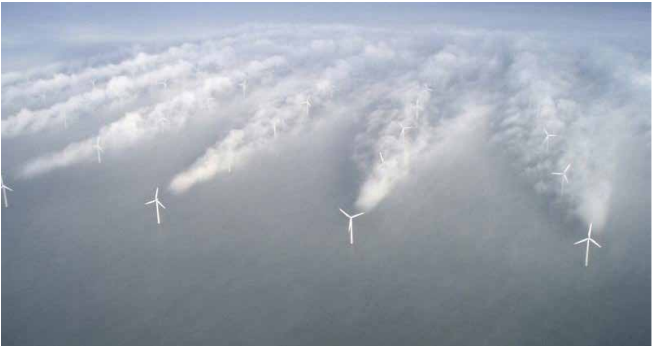
TURBULENTIE IN HET ZOG VAN DE WINDTURBINE
