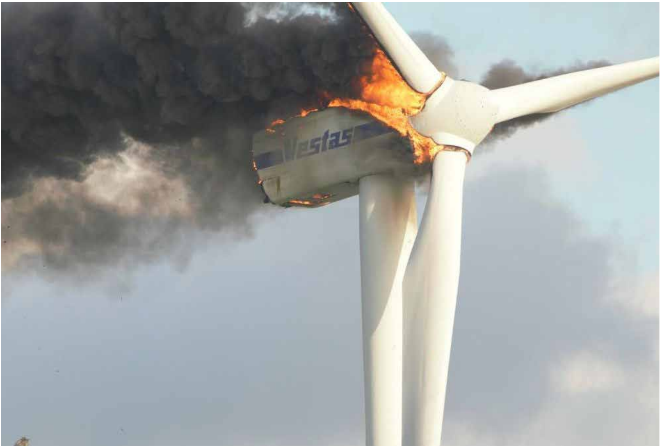
DE GONDEL IS DE ARCHILLESCHIEL IN DE WINDTURBINE
