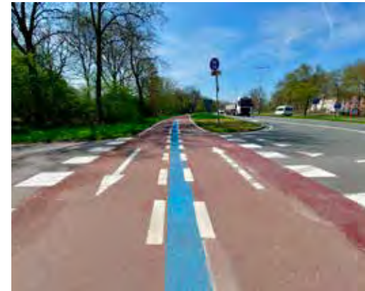
In Utrecht beproeft men markering met een dubbele asstreep, bij kruisingen met blauw ingekleurd.
