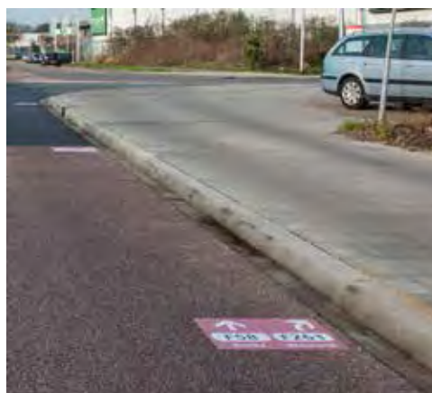
Grondmarkering helpt wel, alleen lieten de proefexemplaren nogal eens los.
