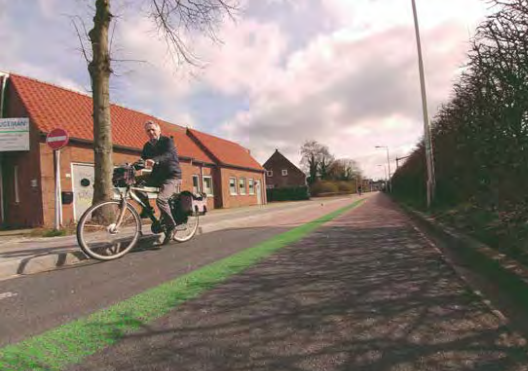
In Utrecht beproeft men markering met een dubbele asstreep, bij kruisingen met blauw ingekleurd.
